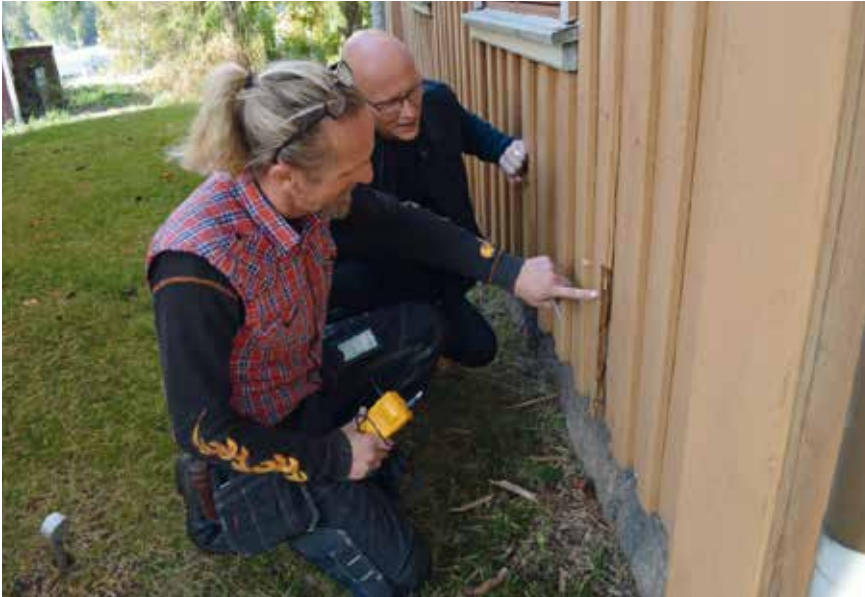
En god del råte er noe av det snekker Trond R. W. Johansen, her sammen med kollega Jørgen Hansen (bak), fant i bygningene tilhørende Gamle Glemmen menighet i 2017. Her har han oppdaget råte i kledningen på gamlestua fra 1700-tallet. Foto: Marianne Holøien, Fredriksstad Blad
